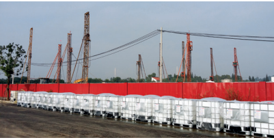
高压旋喷注射 - 原位化学氧化技术工程应用(南京)
